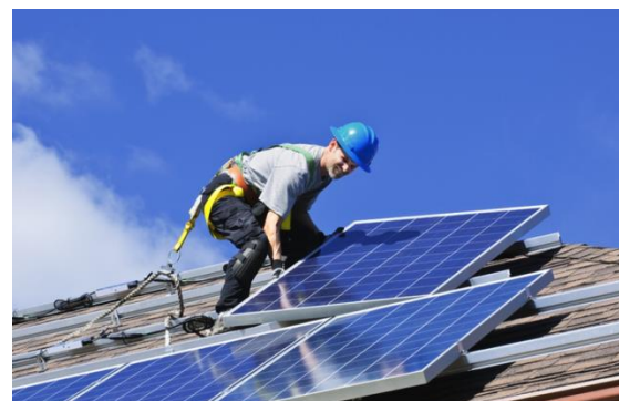
Transport, montaj pe acoperiș înclinat și punere în funcțiune
